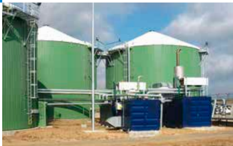
Biogazownia, Hostouň, Republika Czeska
