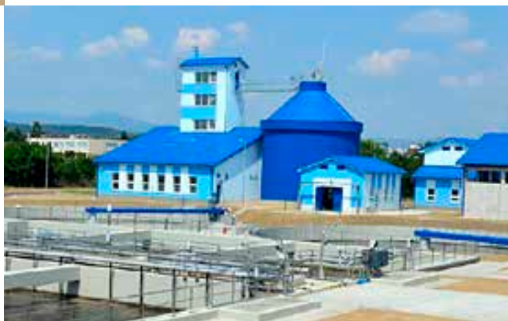
WTP, Nové Mesto nad Váhom, Słowacja
