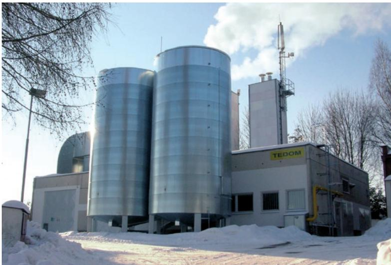
Der Umbau der Kesselanlage „Na Bradle“ war Bestandteil der Modernisierung der Fernwärmeversorgungsanlage in Světlá nad Sázavou. Im Rahmen dieses Projektes wurde hier eine Gesamtverstärkung der Wärmeleistung der Kesselanlage infolge der Auflösung eines anderen städtischen Heizwerks vorgenommen. In der Kesselanlage wurde unter anderem das Blockheizkraftwerk TEDOM Quanto D2000 einschließlich zweier Wärmespeicherbehälter mit einem Volumen 2 x 100 m<sup>3</sup> installiert.
