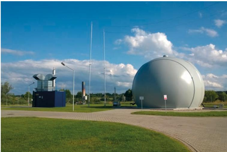
TEDOM Poland nahm im Juni 2015 in der Kläranlage Morag in Polen ein Blockheizkraftwerk der Baureihe Cento in der Containerausführung in Betrieb. Das Blockheizkraftwerk deckt den energetischen Bedarf der Kläranlage und im Falle eines Stromausfalls kann das BHKW auch als Notstromquelle für die Erhaltung der Betriebsfähigkeit der Kläranlage dienen. Die Modernisierung und Erweiterung der Kläranlage wurde von einem Operationsprogramm der EU finanziert.
